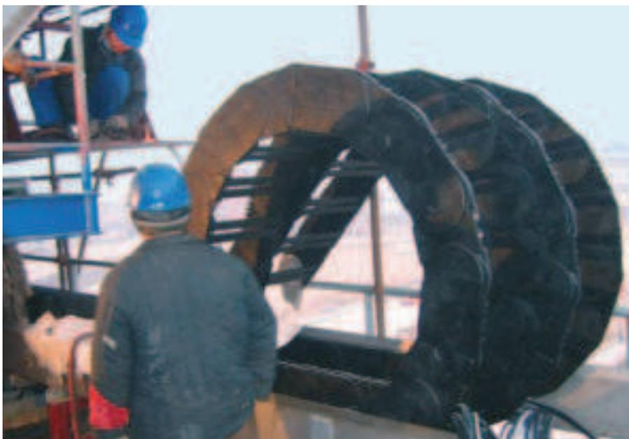
Montage einer E4.1 E-Kette® Serie 800 in igus® Stahl-Führungsrinne
