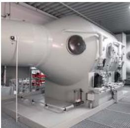
Die Abluft wird direkt über den Becken abgesaugt und mittels Luftwäscher gereinigt. Die vorhandene Wärmeenergie wird zurückgewonnen.
